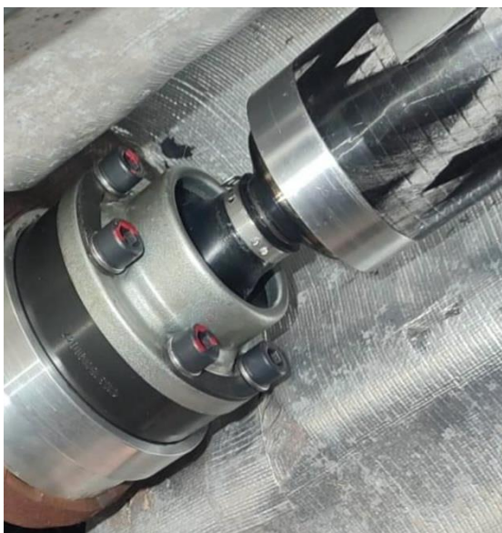
Zdj. nr 3 - Montaż przegubu w kryzę
